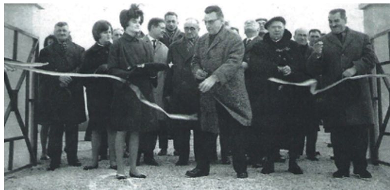
Le 20 février 1965, Monsieur André Jacquinot président du SIEA de Fauverney, inaugure le château d'eau et le réseau d'alimentation d'eau potable.
