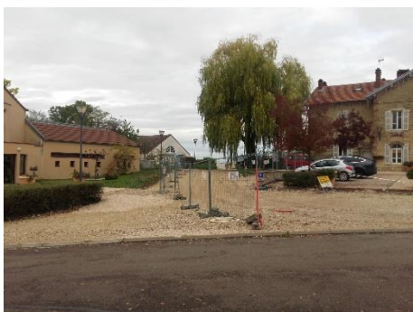
Vue depuis la rue de la Liberté – voie d'accès au groupe scolaire en cours de construction
