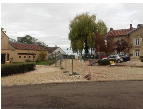
Vue depuis la rue de la Liberté – voie d'accès au pôle scolaire en cours de construction
